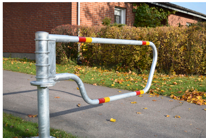
Exempel på vägbom som är tillgänglighetsanpassad för synskadade. Bommen kan ha både manuell och elektrisk öppning via mobiltelefon, och det finns olika behörighetsnivåer som gör att räddningstjänst kan öppna bommen.
