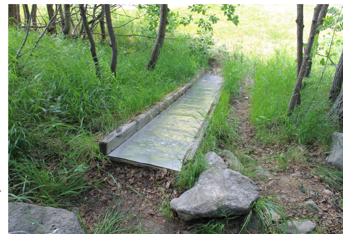
Den befintliga rutschkanan i området rustas upp och får en trapp samt fallskydd.
