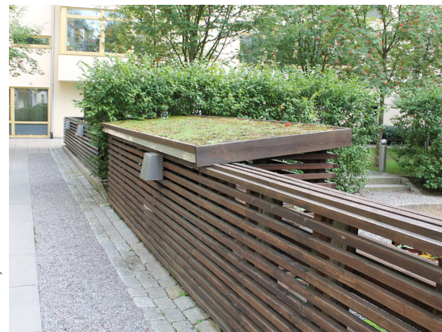
Exempel på skärmtak för cyklar i träpanel av svenskt kärnfuru och sedum.
